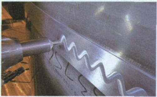
图6 铝合金薄壁结构正弦函数曲线搅拌摩擦焊接
